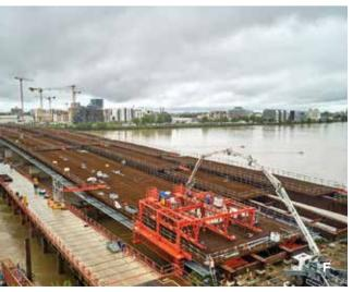
B \_\_\_\_\_ Le tablier du pont repose sur huit piles pleine largeur en béton armé constituées chacune de quatre fûts
