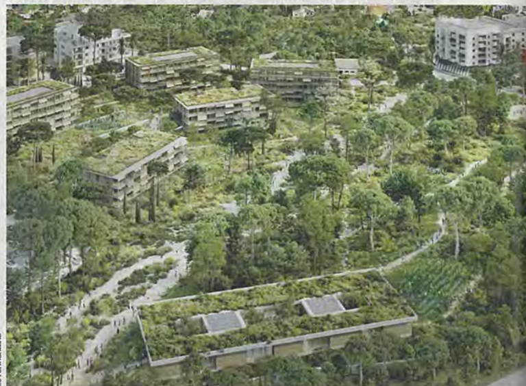
Cinq immeubles en R+3 et R+4 prendront place au sommet de la colline. Une crèche de 70 berceaux s'installera en contrebas.
